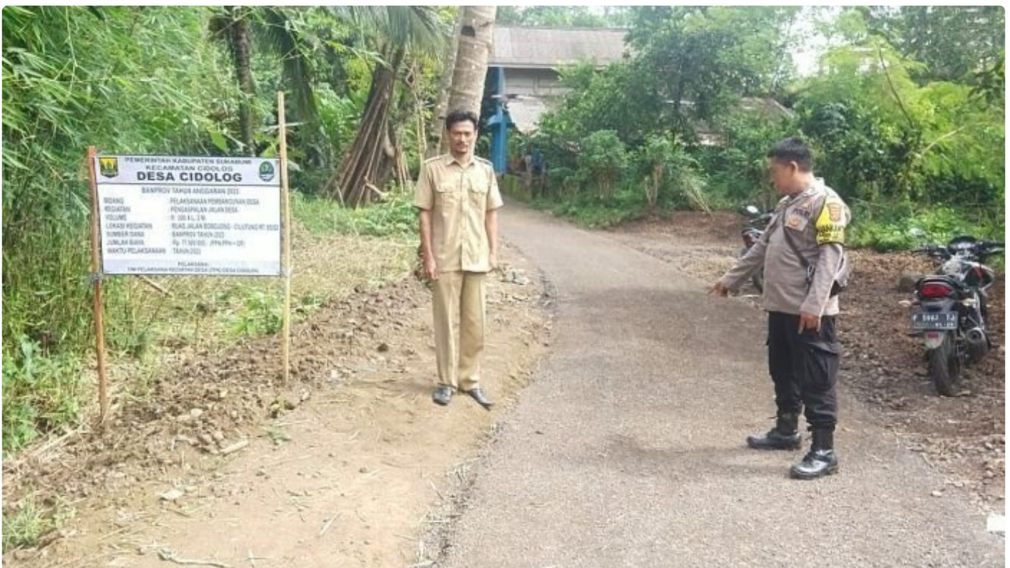
Bhabinkamtibmas Desa Cidolog Awasi Pembangunan Desa
